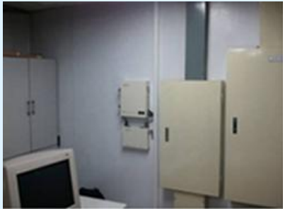
빌딩 바닥 누수 감시
